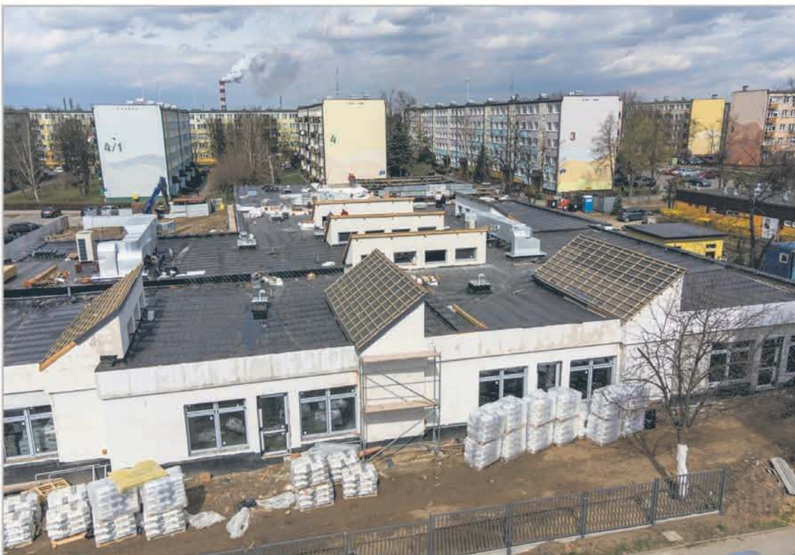
Trwa budowa Miejskiego Przedszkola nr 17 przy ul. Kossobudzkiego
