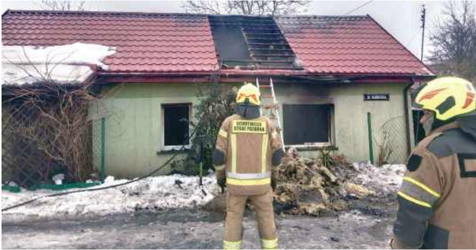
Na miejscu pracowały liczne zastępy straży pożarnej. Strażacy robili wszystko, by opanować sytuację, nie dopuścić do rozprzestrzenienia się ognia i zabezpieczyć teren
