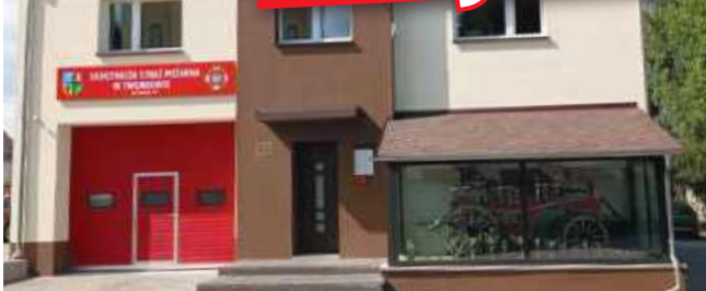
■ Remiza OSP Tworków po remoncie. FOT. UG KRZYŻANOWICE
