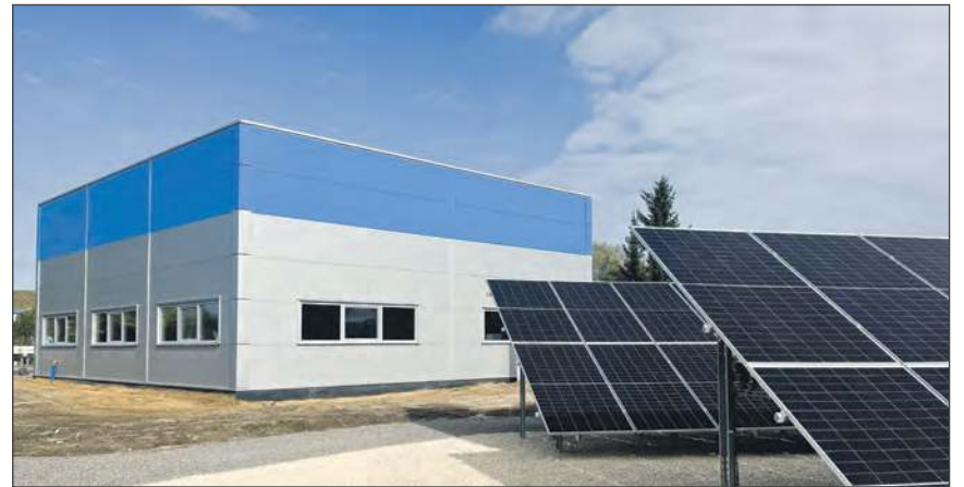
Budynek zajezdni wraz z instalacją fotowoltaiki już jest gotowy. Niebawem do miasta dotrą zamówione autobusy (fot. Urząd Miejski w Dęblinie)
