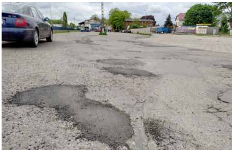
Już po raz drugi w tym roku przeprowadzono częściowe prace na łączniku ul. Dworcowej
