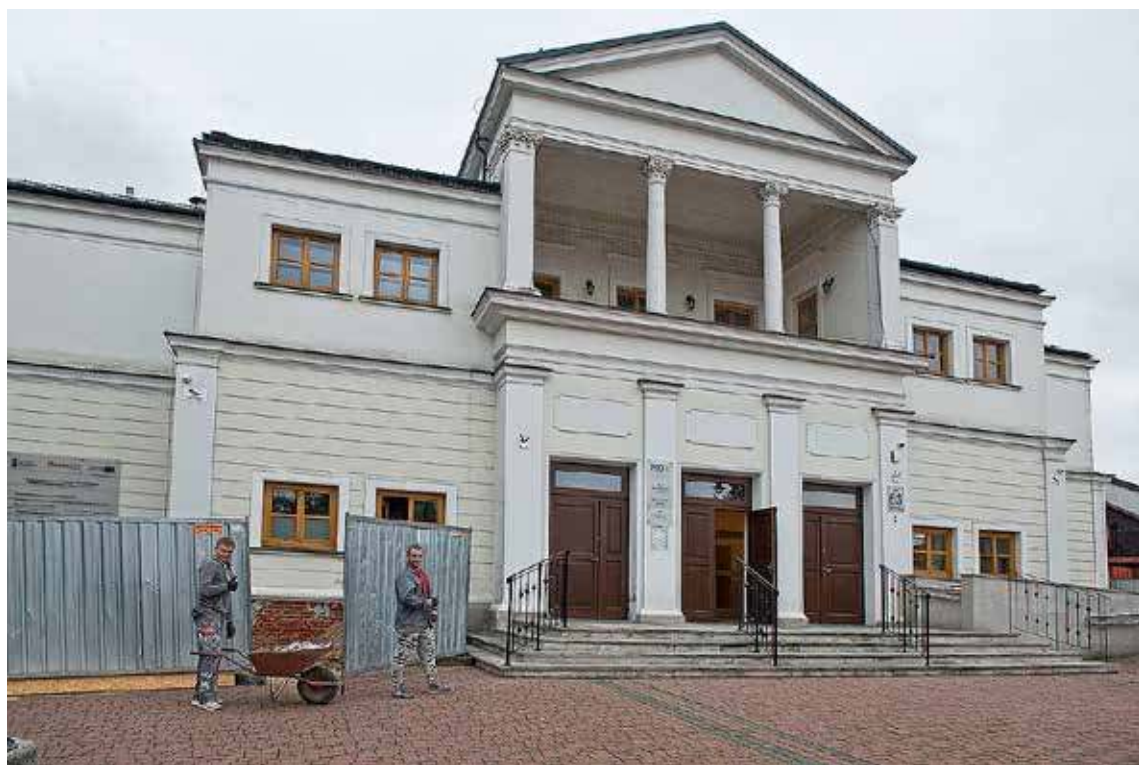
Prace remontowe już się rozpoczęły.
