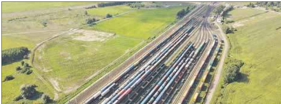
– Modernizacja odbyła się w związku z rozbudową portu przeładunkowego Małaszewicze – mówi Jacek Rutkowski prezes PKP Cargo Terminale
