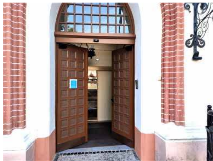
Główne drzwi wejściowe do Ratusza otwierają się automatycznie. Dodatkowo zlikwidowano próg i wykonano spadek w posadzce
