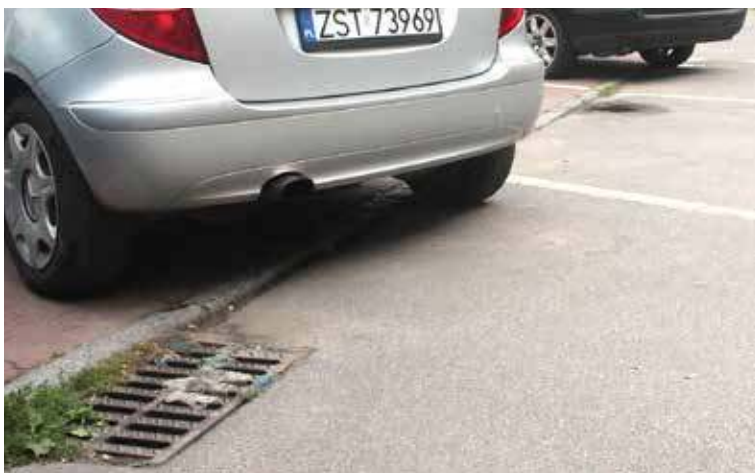
Widoczny na zdjęciu wpust studzienki deszczowej, jak zaznacza radny, jest zapchany
