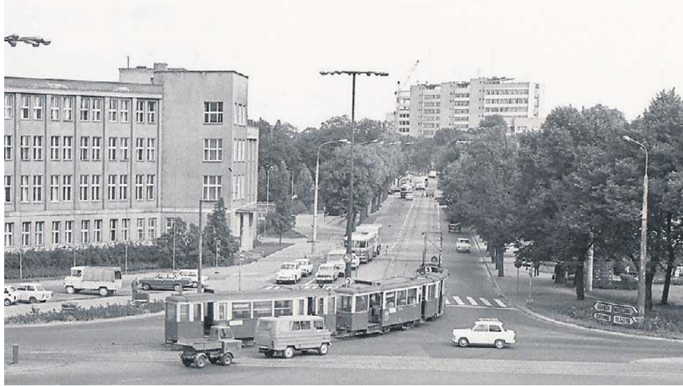
Wieżowce przy Szosie Chełmińskiej (wtedy Nowickiego) w bardziej zaawansowanym stadium budowy (z tyłu w tle)
