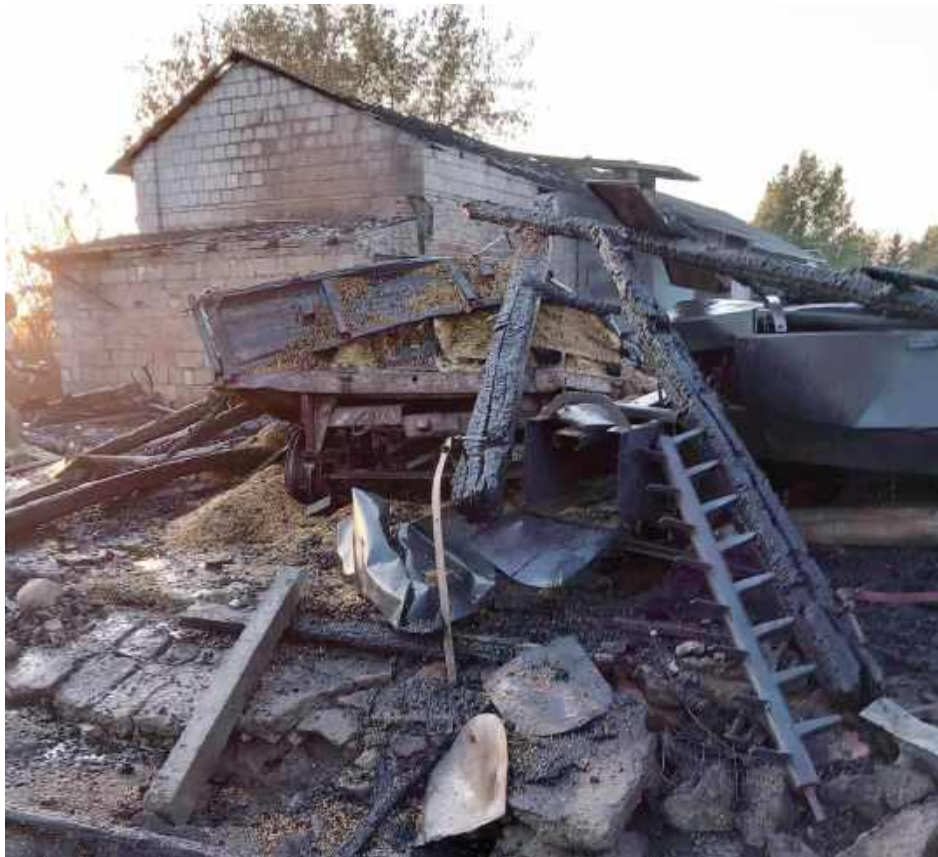
Zniszczenia są ogromne
