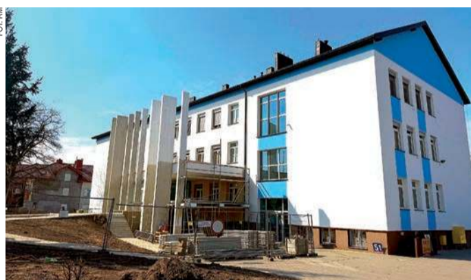
Rozbudowywany budynek PANS przy ulicy Wojska Polskiego w Ciechanowie
