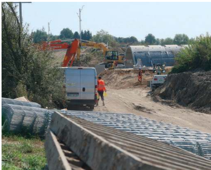
Po wielomiesięcznym przestoju, spowodowanym zejściem z placu budowy włoskiej firmy Astaldi, przebudowa magistrali kolejowej do Warszawy znów idzie pełną parą
