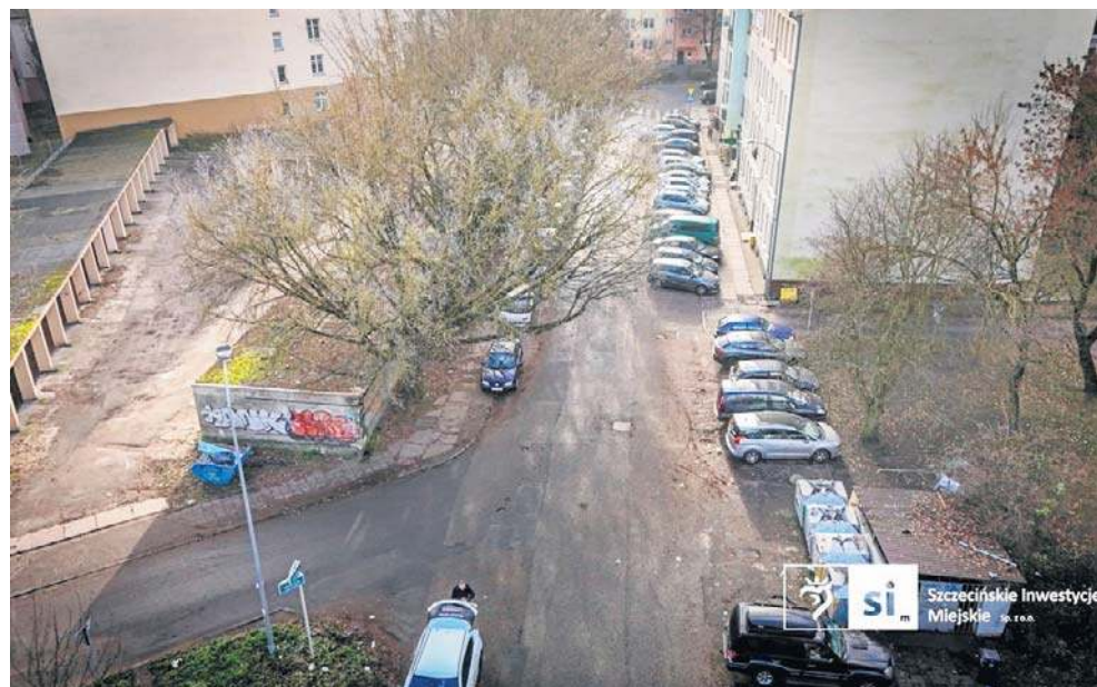
Mieszkańców Drzetowa czeka koszmar komunikacyjny? Trwają przygotowania do remontu nie tylko ulicy Emilii Plater, ale również ulicy Miedzianej
