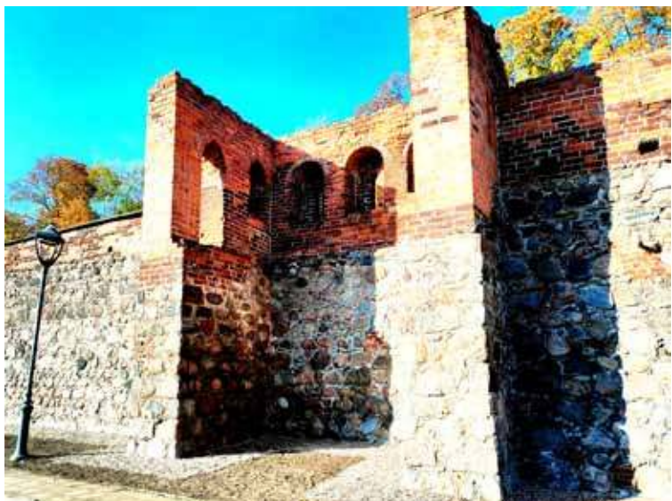
Przy ul. Spichrzowej do wyremontowania i zabezpieczenia jest około 60 metrów zabytkowych obwarowań
