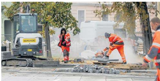
Tak w październiku 2025 roku prezentuje się plac budowy na placu Wolności w Bydgoszczy
