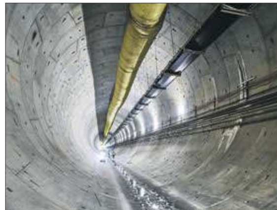
Kontrakt na budowę tunelu kolejowego w Łodzi zawarto w 2017 r.
