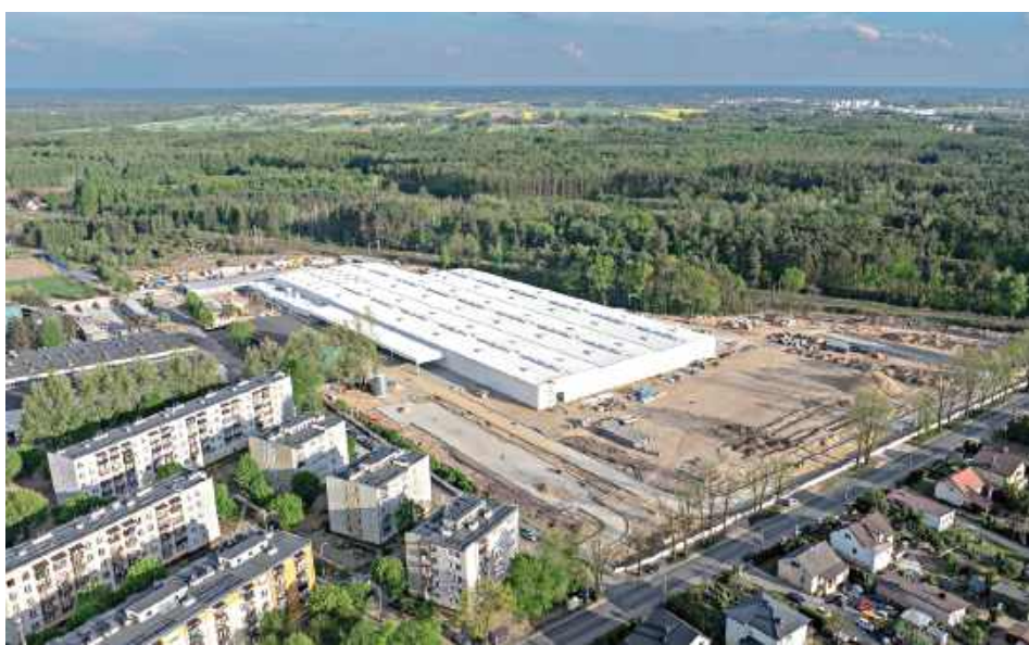
Nowy magazyn ma skupić w jednym miejscu procesy, które dotychczas były realizowane w kilku lokalizacjach na terenie powiatu garwolińskiego.
