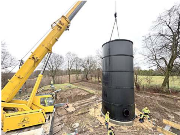
Modernizacja ujęcia wody w Kijanach zapewni bezpieczeństwo mieszkańcom
