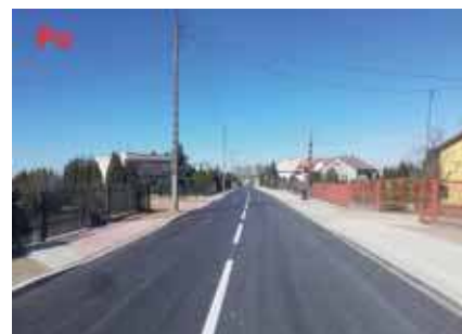
Białowiejska po przebudowie
