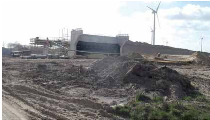
Budowa wiaduktu w okolicy Wiśniewa
