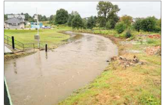
■ Rzeka Sumina sfotografowana z mostu przy ul. Jana Pawła II w Nędzy. Zdjęcie wykonane we wrześniu ubiegłego roku. FOT. JAKUB KWIATKOWSKI
