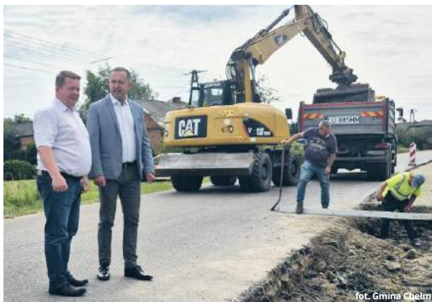
Prace drogowe w Horodyszczu
