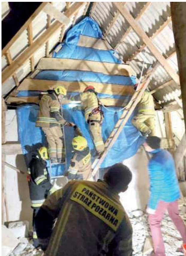
Strażacy uszczelniają folią uszkodzony dach
