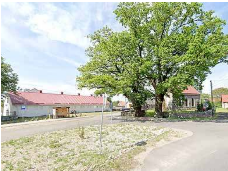
W planie remont drogi wewnętrznej w Świerczewie, obecnie należącej do KOWR
