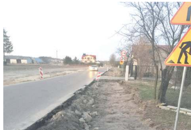
W Nowodworze powstanie droga o nowej nawierzchni oraz obustronne ścieżki rowerowe
