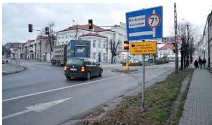
Gdy powstanie obwodnica Pułtуска, część samochodów nie będzie przejeżdżać przez centrum miasta przy zabytkowych obiektach jak budynek MCKiS (po prawej stronie)
