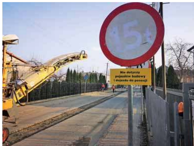
Trwają prace na ul. Bema w Głinojecku, ruch czasowo został ograniczony
