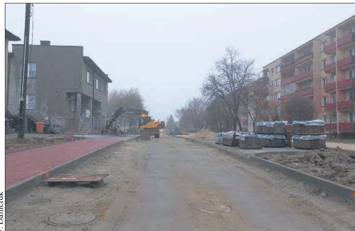
Przebudowa fragmentu ulicy Lasockiego
