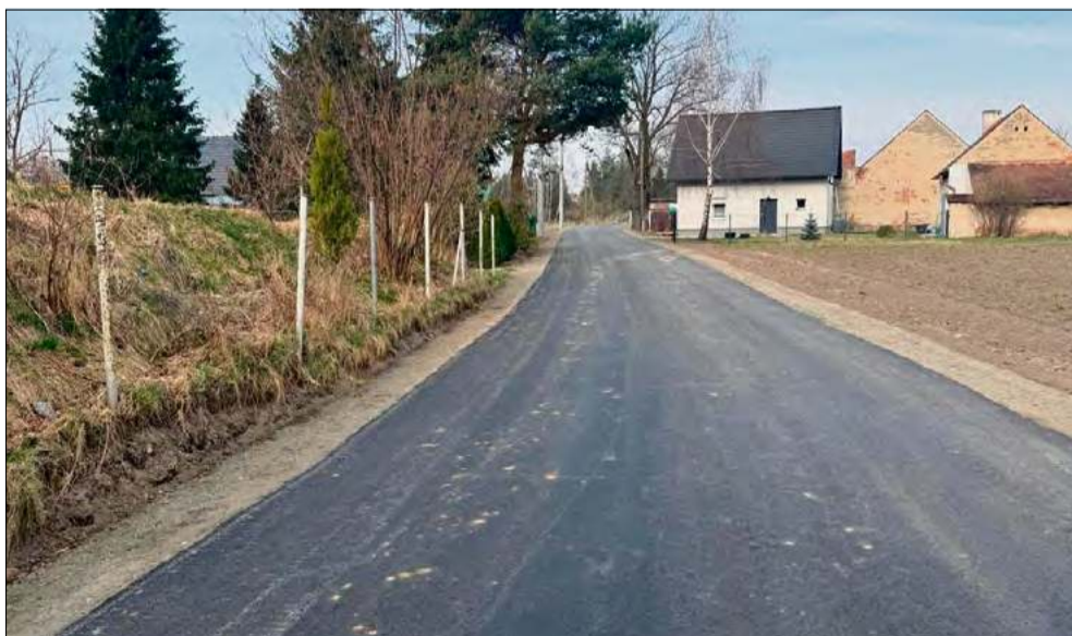
Zadanie obejmuje wykonanie nowej nawierzchni na odcinku o długości 585 metrów.
