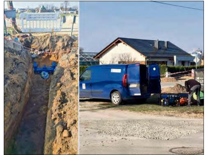
Zakończenie robót przez PUKTO umożliwi podłączenie nieruchomości przy ulicy Nakielskiej do nowego systemu przesyłowego.
