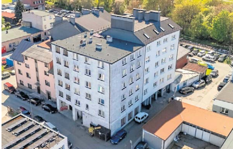
Blok jest przeznaczony do rozbiórki. Wciąż mieszka tam ok. 100 osób
