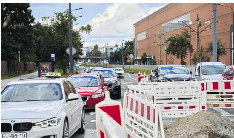
• Remont na skrzyżowaniu Al. Politechniki z ul. Wróblewskiego
