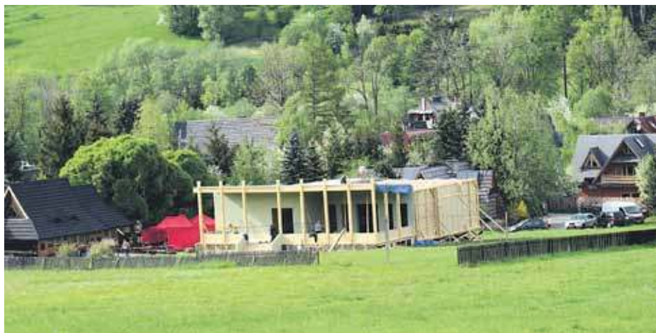
Budowla powstająca na Lipkach przerażała okolicznych mieszkańców.
