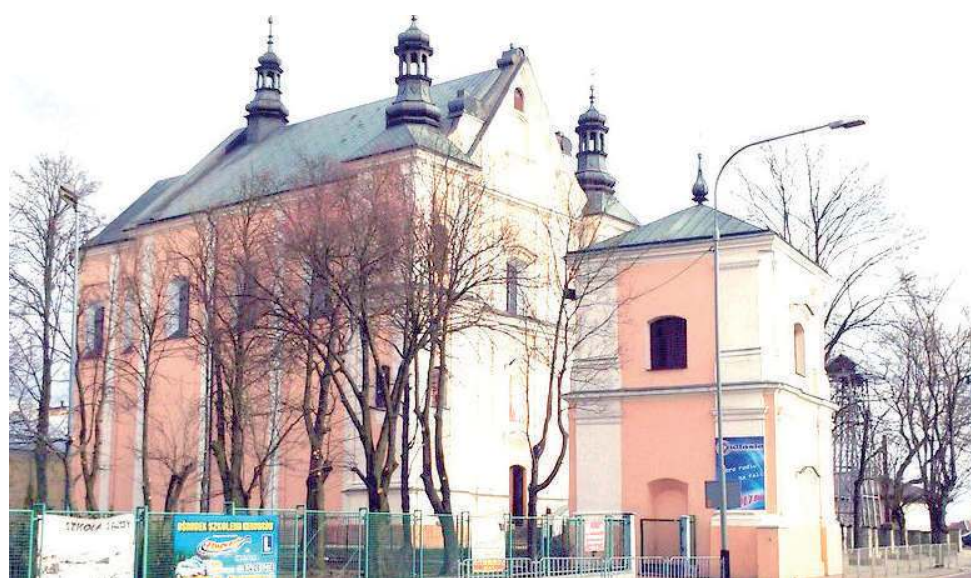
Kościół pw. Podwyższenia Krzyża Św. w Łukowie. Archeolodzy będą badali jego krypty. Budowę tego kościoła i klasztoru rozpoczęli bernardyni w 1655 r. Przewidywano ją na 3 lata, jednak zubożenie miasta i ciężkie losy w dalszych latach wydłużyły czas budowy tak, że ukończono ją dopiero w 1770 r.
