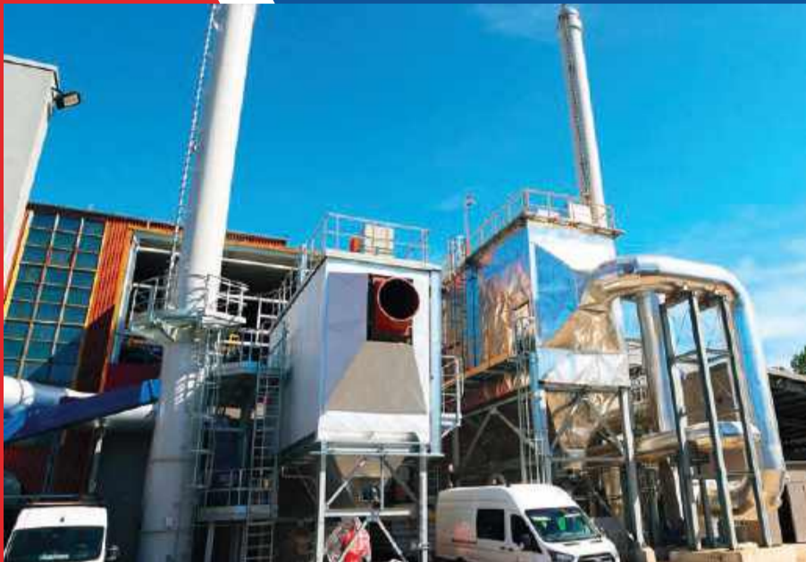
Nowe inwestycje w Elektrociepłowni Ciechanów
