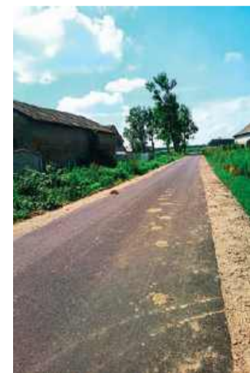
Wyremontowana droga w Jonnem
