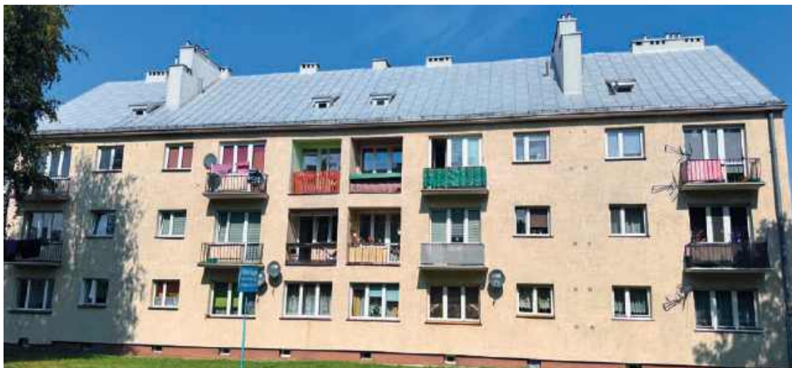
Najstarszy budynek SM Zamek w Ciechanowie, ul. Pułtuska 8/10, wybudowany w latach 60. ub. wieku. Tu woda podgrzewana jest piecykami gazowymi.
