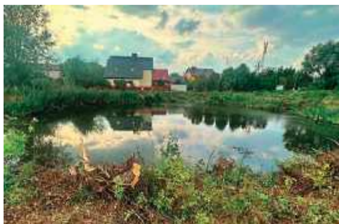
Gmina rozpoczęła modernizację stawu w Załuskach
