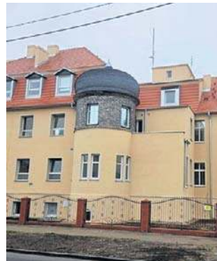
Modernizacja budynku dobiegła końca
