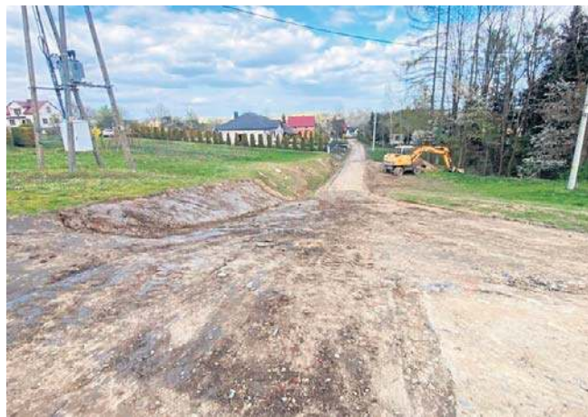
Na ul. Brzozowej prowadzone są prace ziemne. Modernizacja obejmuje również odwodnienie drogi
