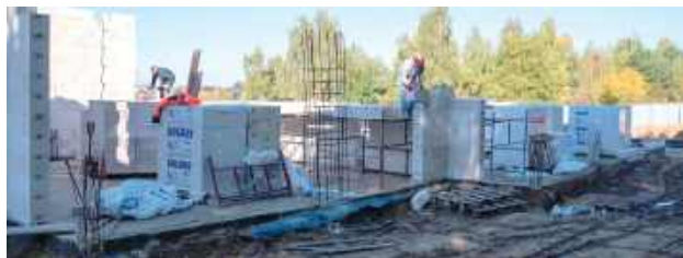
Byliśmy na budowie przedszkola rok temu, zaraz po tym, gdy wybudowane zostały piwnice i pierwsze ściany budynku. Teraz trwają prace wykończeniowe
