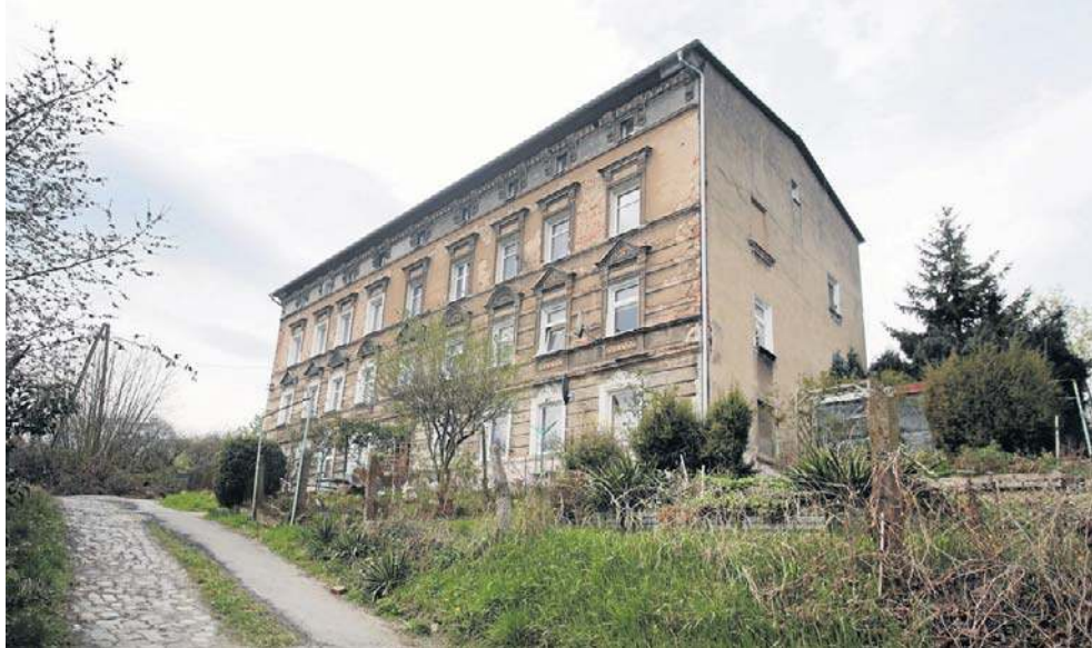
Remont kamienicy przy ul. Światowida 59 ma docelowo poprawić standard mieszkań, w tym poprzez wykonanie łazienek oraz modernizację instalacji grzewczych
