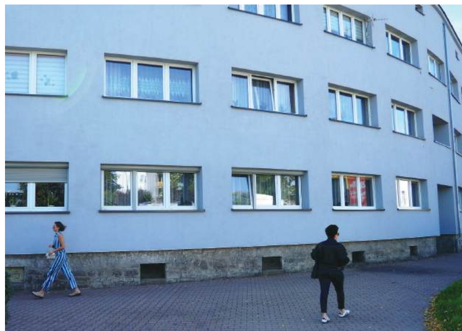
Piwnice w blokach przy ulicy 1 Maja w Strzelinie mogą być schronami tymczasowymi
