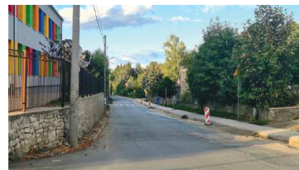
W Prusach prowadzone są prace związane z modernizacją kanalizacji sanitarnej. Fot. UG w Kondratowicach
