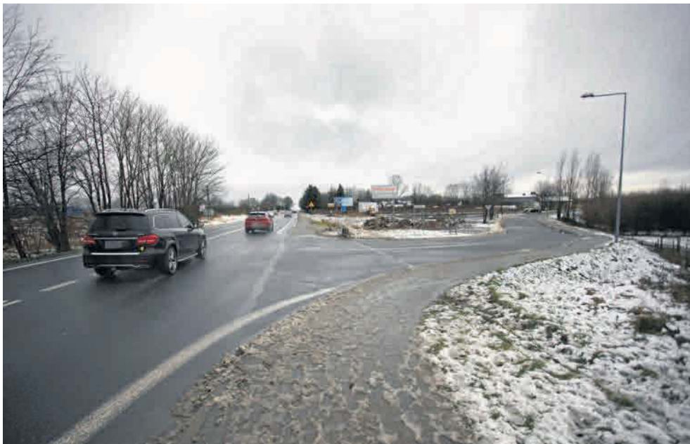
Rada zgodziła się na nadanie nazwy ul. Granicznej drodze odchodzącej od ulicy Portowej w kierunku Włynkówka. Ulica nie tylko z nazwy będzie oddzielać teren miejski od gm. Słupsk
