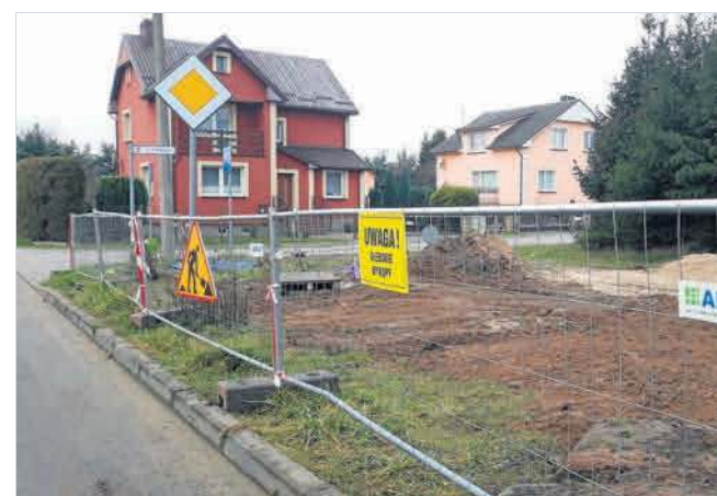
Cześć prac przy budowie sieci ciepłowniczej w Potęgowie jest już ukończona. M.in. w odcinku od ul. Szerokiej do Kwiatowej
