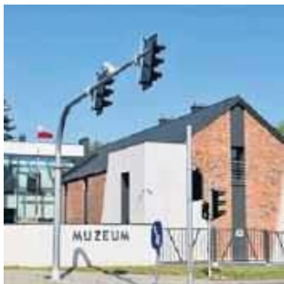
Budynek nowego muzeum w Tarnowie można podziwiać w całej okazałości, ale wciąż stoi zamknięty na cztery spusty
