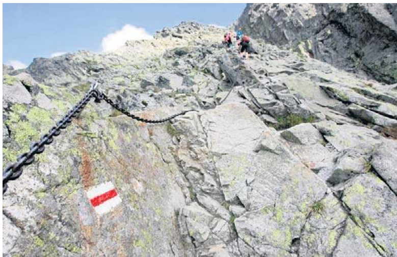
W ramach prac wymienione zostaną łańcuchy asekuracyjne
