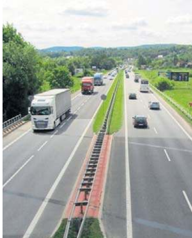
Drogi wzdłuż zakopianki będą modernizowane
