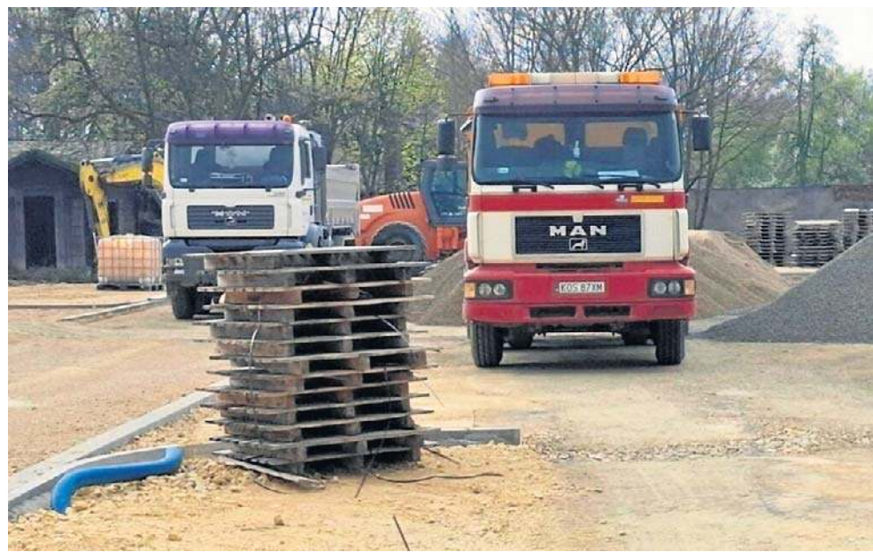
Przy ul. Więźniów Oświęcimia powstaje nowy parking. Planujemy oddać go do użytku w czerwcu - informuje przedstawiciel inwestora
