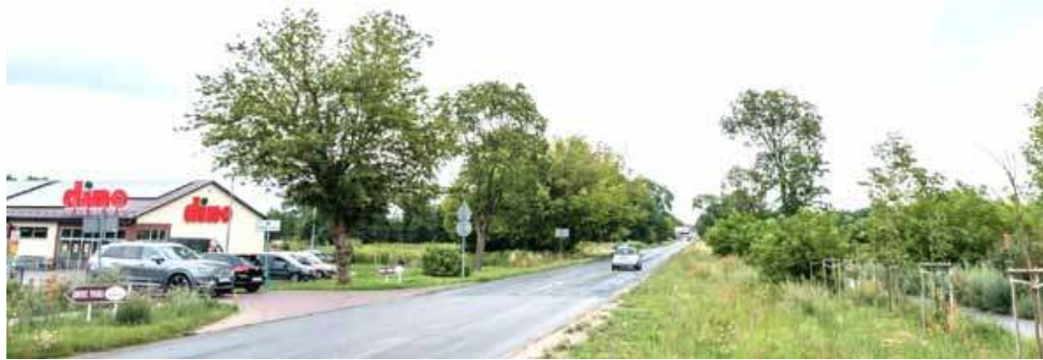
Z PŁ popłyną środki m.in. na modernizację odcinka drogi od Kobylanka Park w kierunku Morzyczyna
