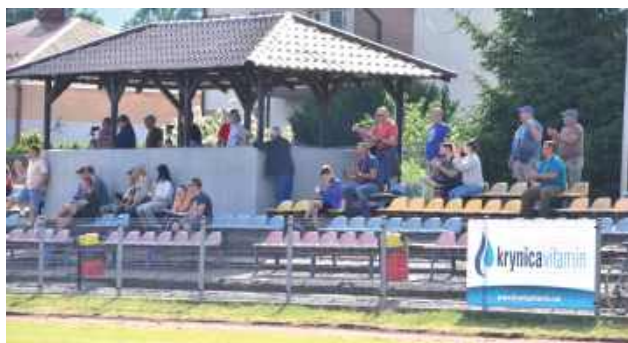
Znajdujące się w bardzo złym stanie trybuny na międzyrzeckim stadionie już niedługo doczekają się nowej odsłony
