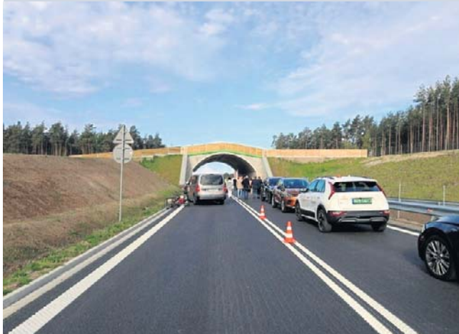
Jeszcze w tym roku planowane są przetargi na budowę dwóch kolejnych odcinków S-11
