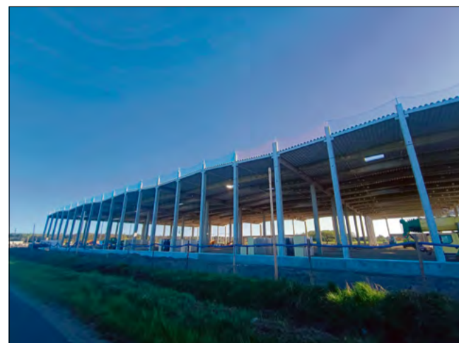
O budowie nowego obiektu przy ulicy Lędzińskiej pisaliśmy już kilkakrotnie na łamach naszej gazety „Tygodnik Ziemi Opolskiej”.
