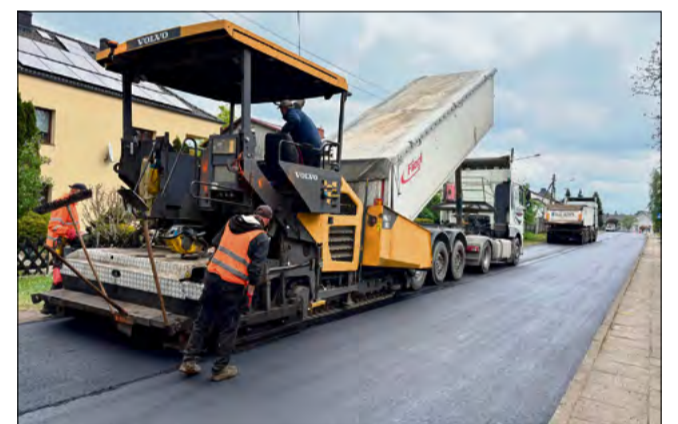
Remont nawierzchni na ulicy Kamiennej w Ciepeliowicach.
