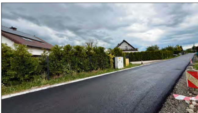
Przebudowa ulic Zielonej w Chróście.
