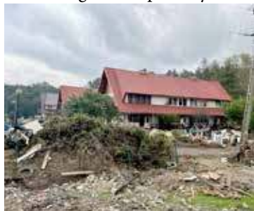
Zalane domy, zniszczone drogi
