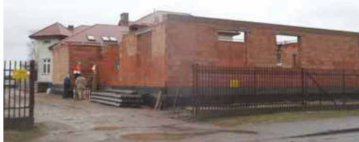
Rozbudowa obiektu SP w Dzierzgowie
