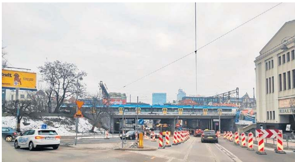
Otwarto przejazd pod wiaduktem na ul. Mikołowskiej w Katowicach
